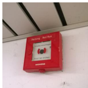
2 bestehender Notaus-Schalter Heizung
